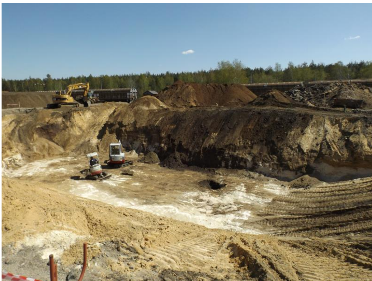
Obr. 2: Sanační výkop s viditelným průnikem kreosotového oleje přes eluvium pískovců (mocnost cca 6 m) až na skalní pískovcový masiv (3. 5. 2020)
