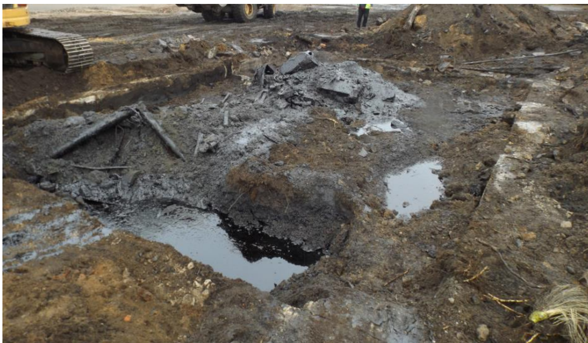
Obr. 1: Odkrytá jímka bývalé technologie tlakové impregnace o půdorysu 9,5 x 7,3 m a hloubce 1,5 m s celkovým objemem cca 104 m 3 (4. 2. 2020)
