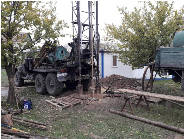
Obr. 3: Vrtné práce na vrtu MW-1
