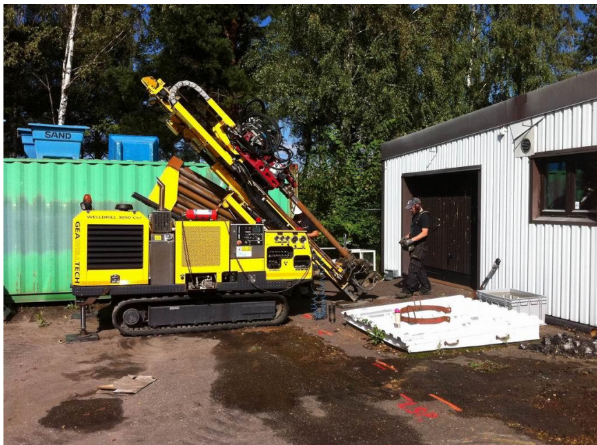
Obr. 3: Provádění šikmého vrtu pod budovu laboratoře
