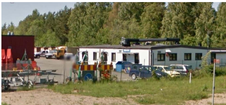
Obr. 1: Pohled na budovu laboratoře s podložím kontaminovaným TCE
