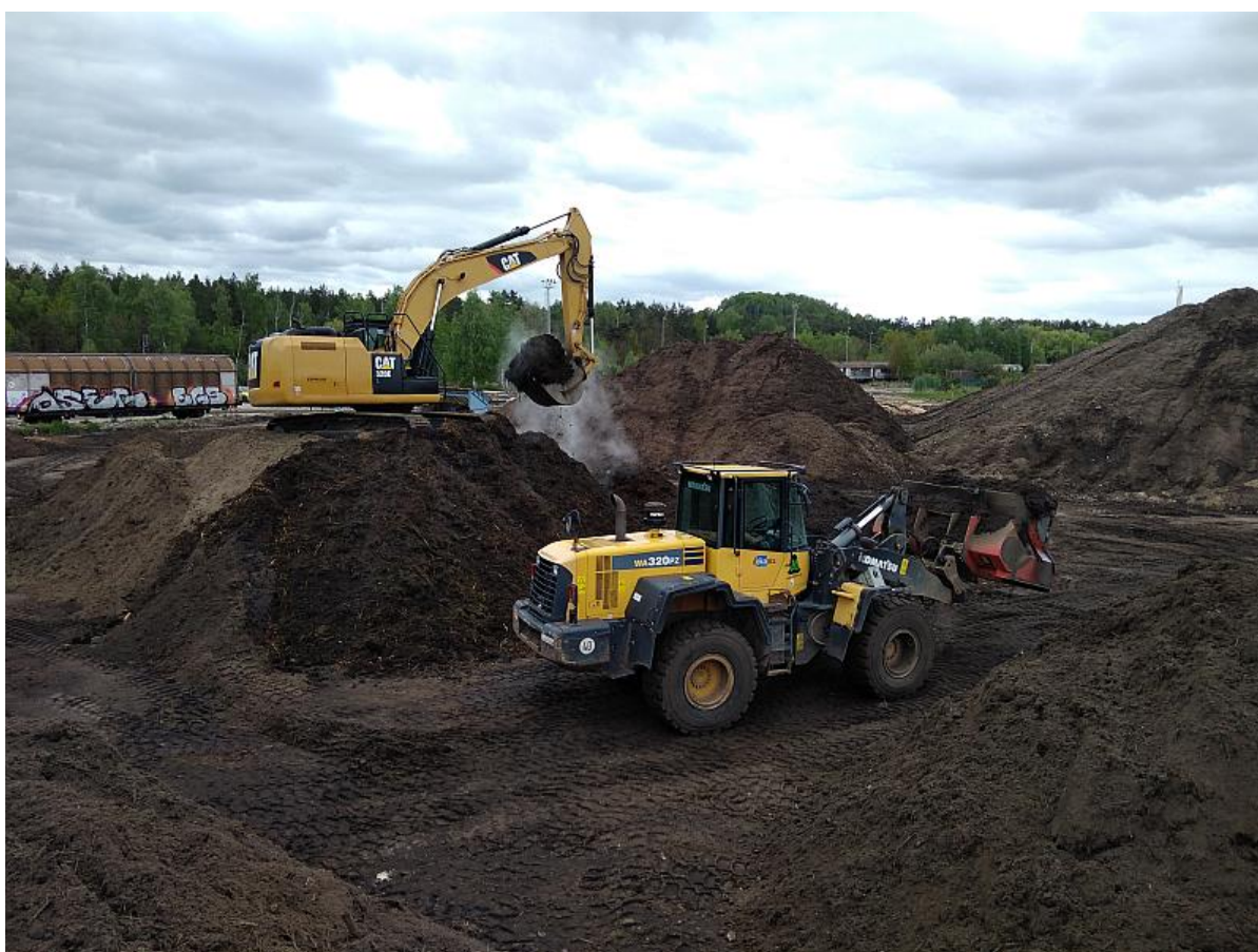
Obr. 4: Míchání homogenizovaných kontaminovaných zemín odtěžených ze segmentu 2 s organickým substrátem (26. 5. 2021)
