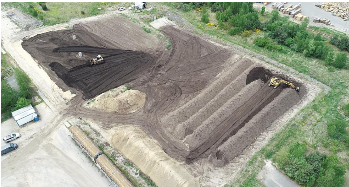
Obr. 6: Zavážení sanačního výkopu přečištěnou zemínou a přesun zemin z podzimu 2021 na okraj bioaugmentační plochy (20. 5. 2022)
