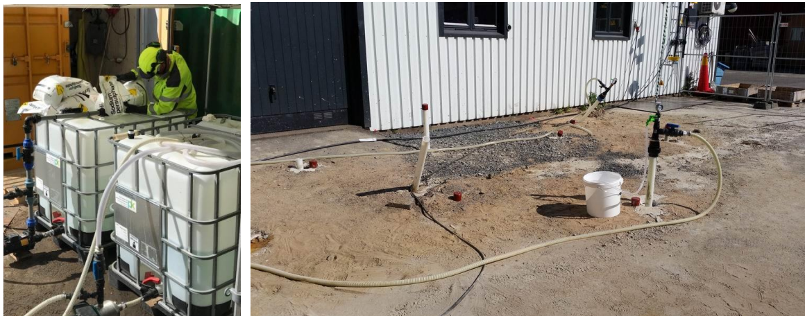
Obr. 9: Příprava a infiltrace chemických oxidačních činidel v lokalitě
