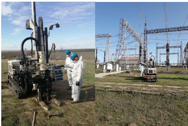
Obr. 2: Sondážní práce – oblast ZONE I a Substation area
