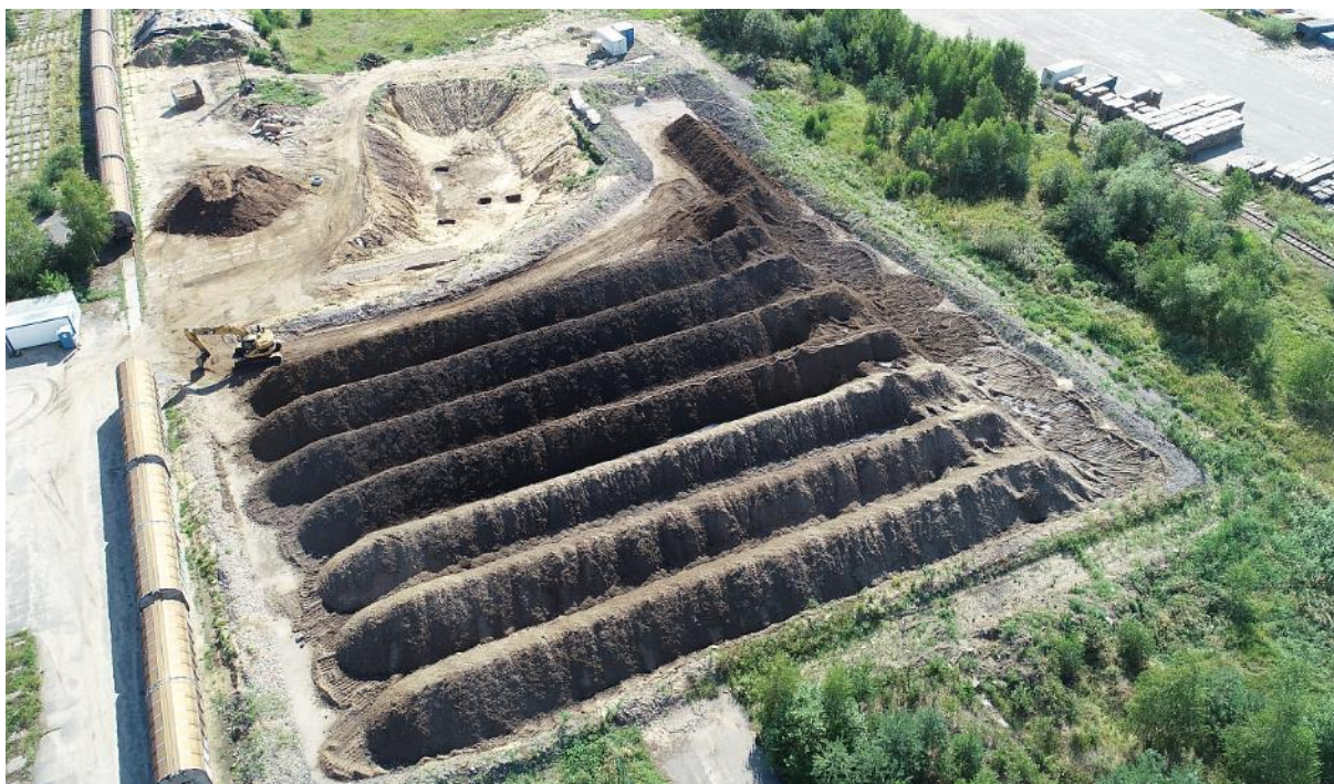
Obr. 3: Plně využitá bioaugmentační plocha v průběhu bioaugmentace kontaminovaných zemín (19. 8. 2020)
