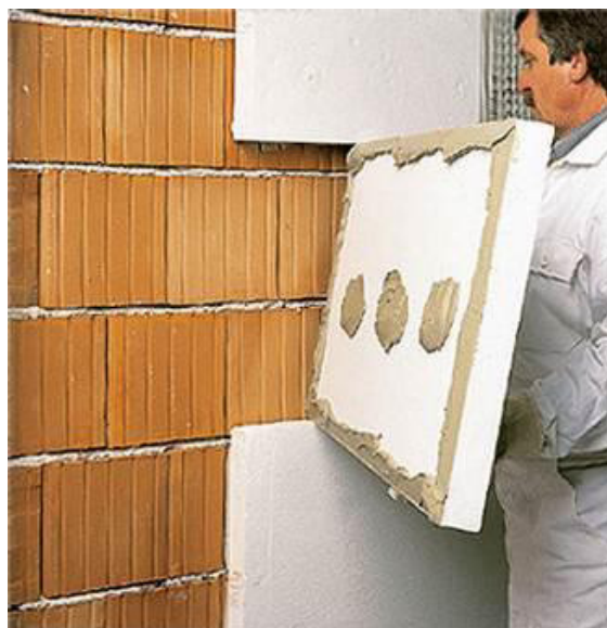
Obr. 1 - Příklad použití výrobku Baumit EPS-F
