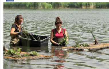
INSTALACE PLOVoucÍH OSTRŮVKŮ. FOTO: SVĚTEN ENERGY
